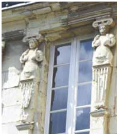
Détail de la façade renaissance de l'hôtel Boulain (16 e siècle)
